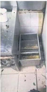
餐馆业者往往没有维护滤油器，一旦损坏就置之不理，严重影响周边环境。
