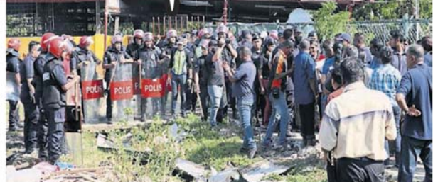
■信徒一度聚集在庙地内，惊动防爆部队进入庙地隔起防线，把信徒全部驱离至拆除范围外。
